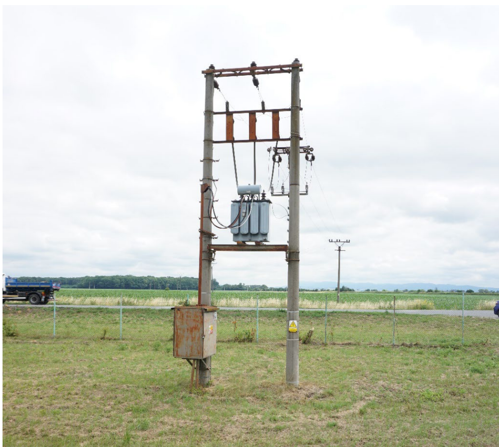
Obrázek 4 – Stávající sloupová trafostanice s hlavní rozvaděčem
